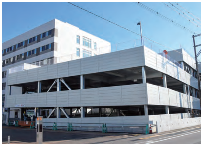
駐車場混雑解消に新設された立体駐車場(2022年12月下旬より利用)
